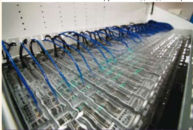
Рис. 7. Серверы для охлаждения погружены в жидкий диэлектрик
