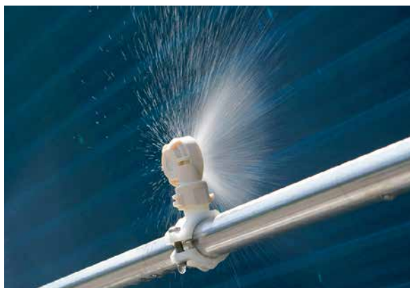
Рис. 3. Форсуночная адиабатическая система с поверхностным испарением
