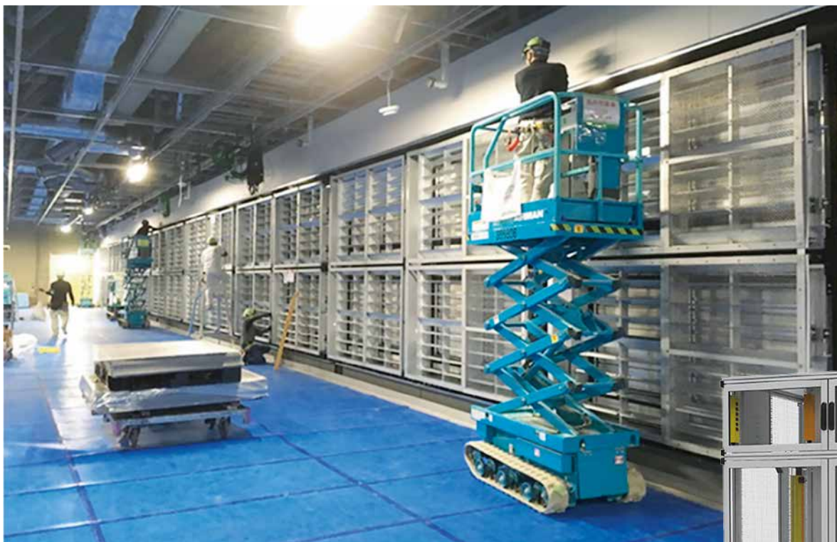
Рис. 9. Блоки АНУ, как большие кубики, формируют единую стену охлаждения внутри ЦОДа
