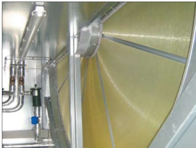
Рис. 2. Вращающийся регенератор (вид в рабочей конструкции)
