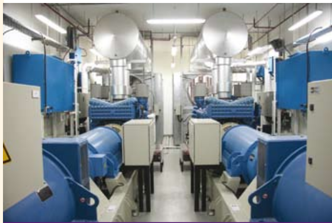
Рис. 1. Динамические дизельные ИБП в действующем ЦОДе
