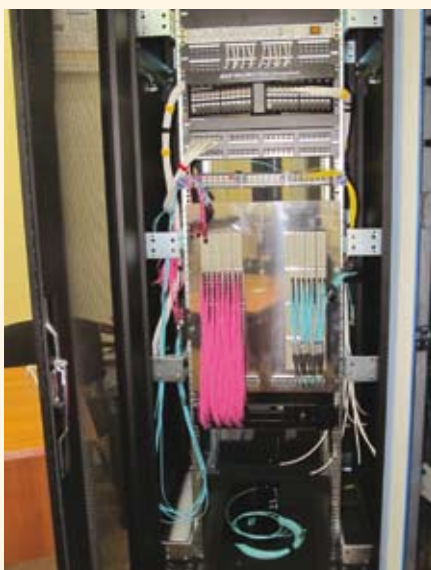
Компания «Линдекс» совместно с Huber+Suhner продемонстрировала подход к подключению оптических коммутаторов типа Brocade – при помощи оптических претерминированных кабельных сборок
