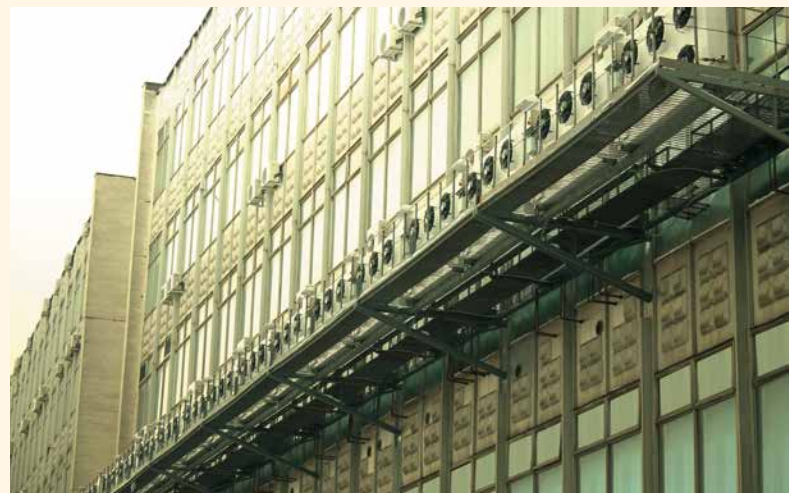
Балкон для наружных блоков кондиционеров четвертого зала
