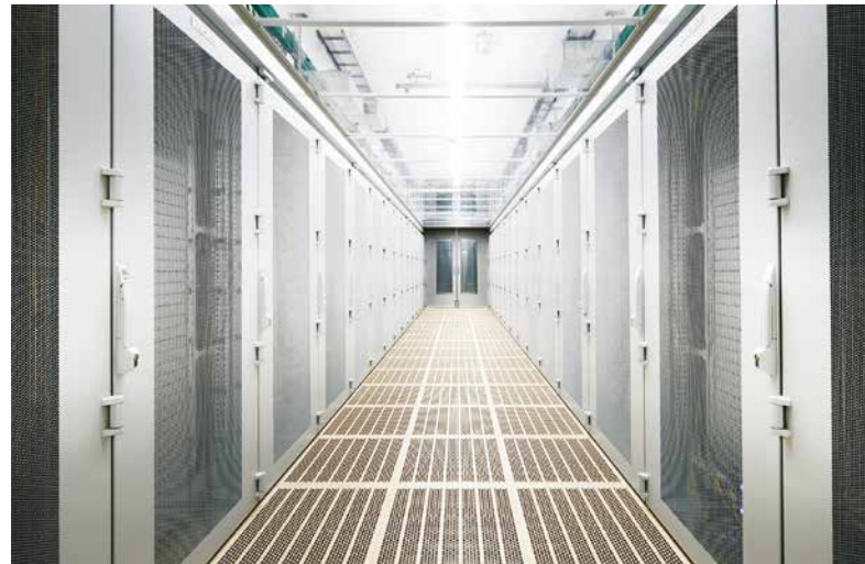
Одинаковая конструкция всех шкафов упрощает реализацию системы отделения холодных коридоров за счет ускорения монтажа ее элементов
