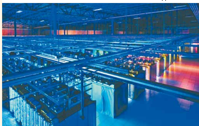
Рис. 3. Дата-центр Google: плоскостное расположение, быстровозводимый металлический каркас и легкие сэндвич-панели
