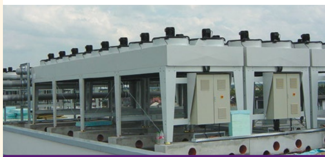
Классическая система наружного воздушного охлаждения ЦОДа
