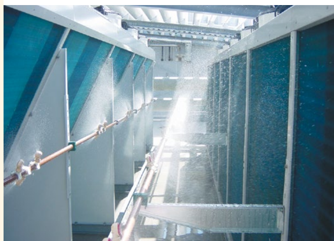
Наружное воздушное охлаждение ЦОДа с применением орошения
