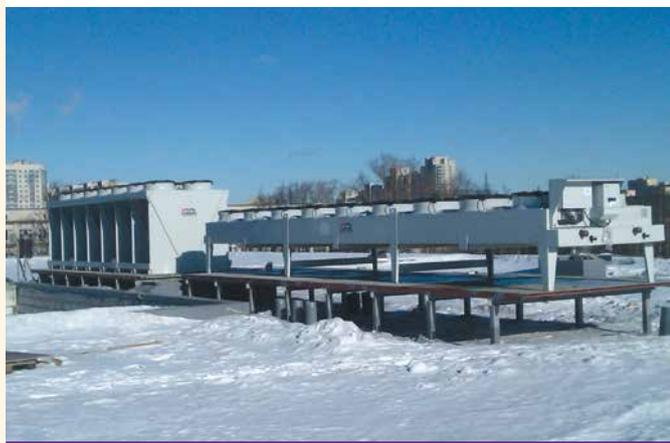
В связи с этим родилась гениальная, на мой взгляд, идея: разместить трубную разводку от контура охлаждения конденсаторов непосредственно в пространстве кровельных перекрытий.
