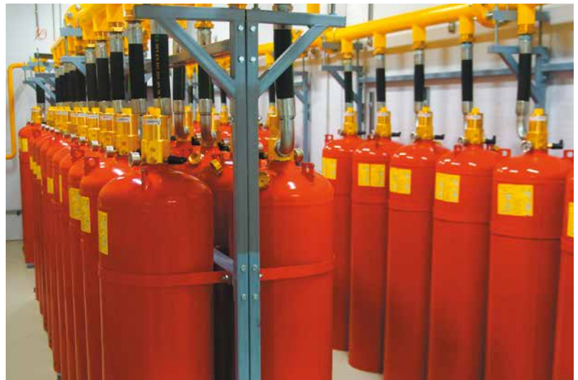
Система автоматического газового пожаротушения
