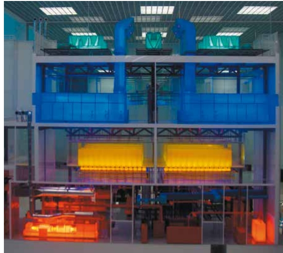
Мaket типового модуля мегаЦОДа: на первом этаже размещается энергетическое оборудование, на втором – серверные залы, на третьем – системы вентиляции и охлаждения
