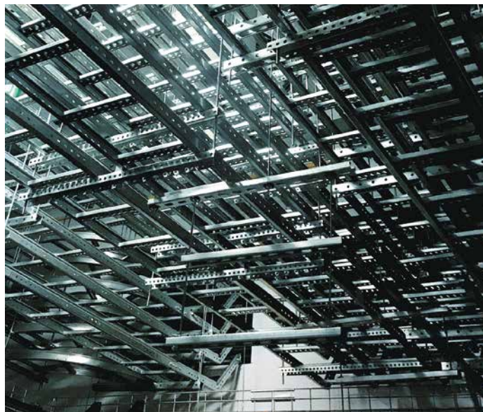
Кабеленесущая система в ЦОДе компании «Мегафон»
