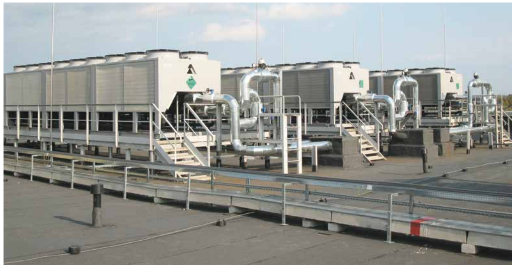
Система охлаждения – традиционная, с чиллера- ми на крыше
