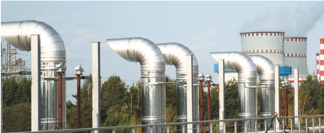
На переднем плане – выхлопные трубы дина- мических ИБП ЦОДа, на заднем – градирни Калининской АЭС
