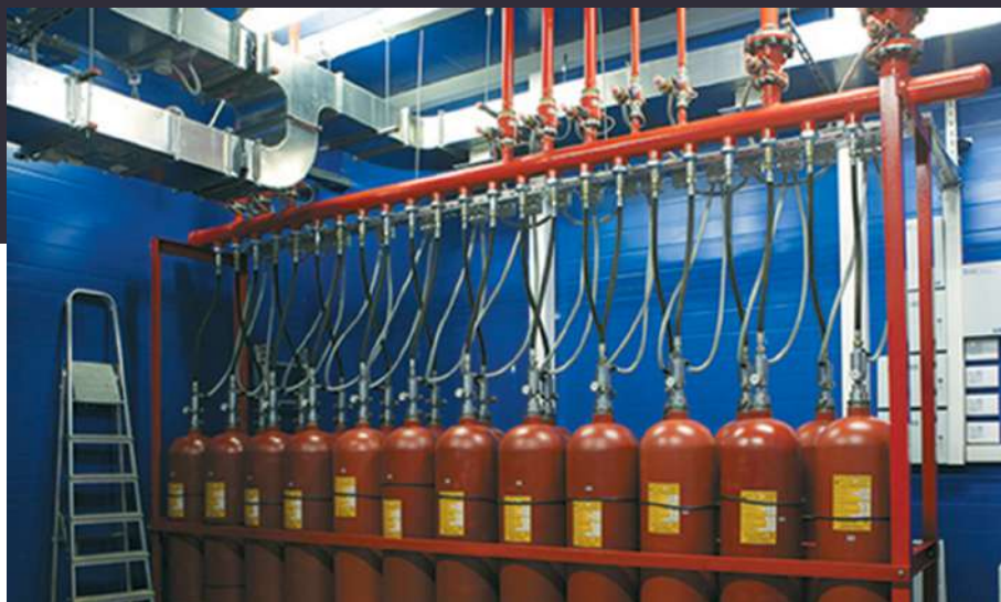
Система автоматического пожаротушения в дата-центре «Яндекса»
